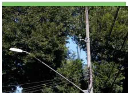
Figura 40 – Túnel em rede compacta
