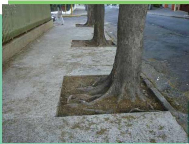
Figura 45 – Canteiro ampliado e piso de calçada refeito
